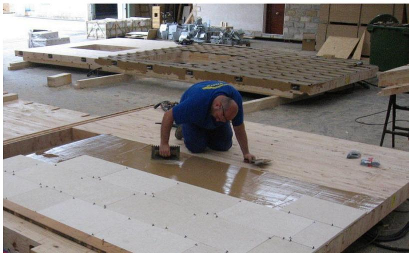
Dans le cas d'un revêtement mural extérieur collé, le produit utilisé est un adhésif élastique mono-composant (sans solvant) – **SIKABOND-T52FC** – qui assure également la fonction de pare-pluie. Le taux d'humidité relative du bois lamellé collé (âme) doit être compris entre 10 et 15% pour une parfaite application de l'adhésif.
